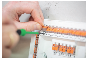
Klemme aus Aufnahme lösen.
