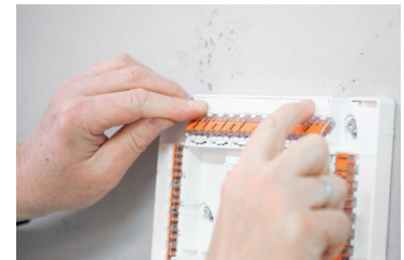
Beschriftungsstreifen in Aufnahme einrasten.
