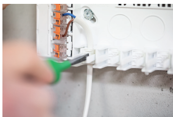
Kabel in Zugentlastung einsetzen.
